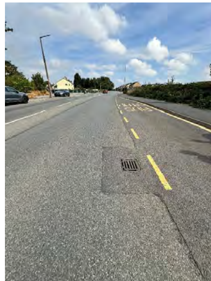
34. Gully bus layby .
