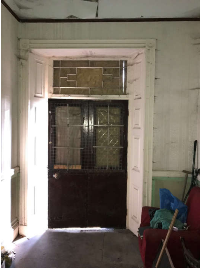
Existing Front Door D1
