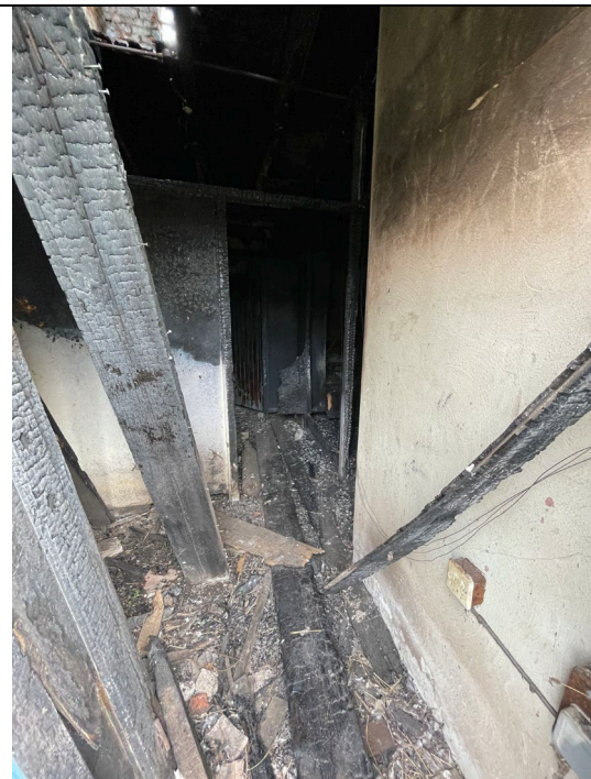
20. Mian Building Internal
