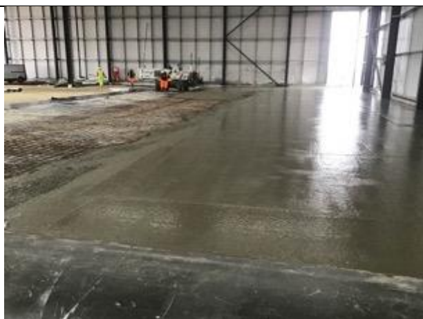
Pour 3 of 4 laser screed installation
