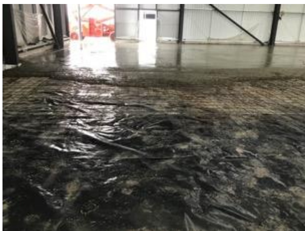
Pour 3 of 4 laser screed installation
