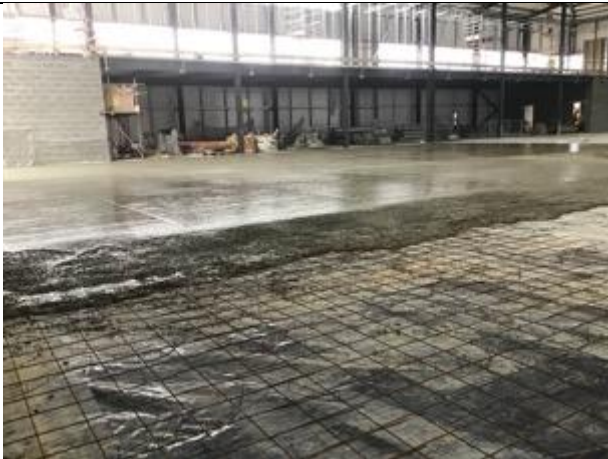
Unit 3 pour 2 laser screed installation
